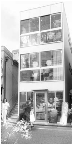
生活道路の緑小通りに面したガラス面を持つ建物
